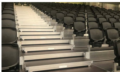
▲跳ね上がり式シートで、収納時に約85cmの通路幅を確保
