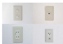
▲スイッチ、弱電配線、 コンセント
