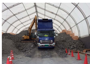
▲ トンネルずり仮置場
