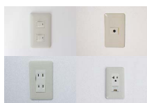
▲スイッチ、弱電配線、コンセント
